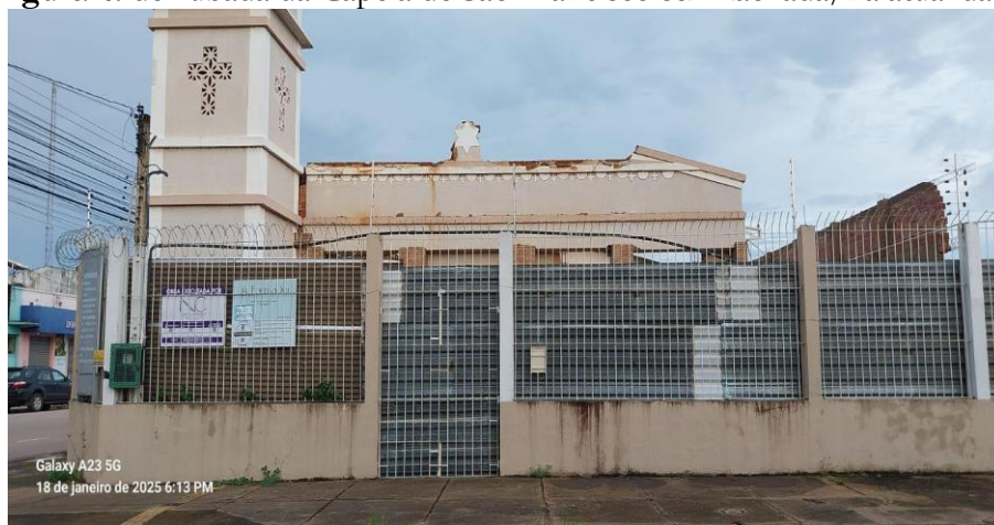
Figura 4: derrubada da Capela de São Francisco sem fachada/na atualidade
