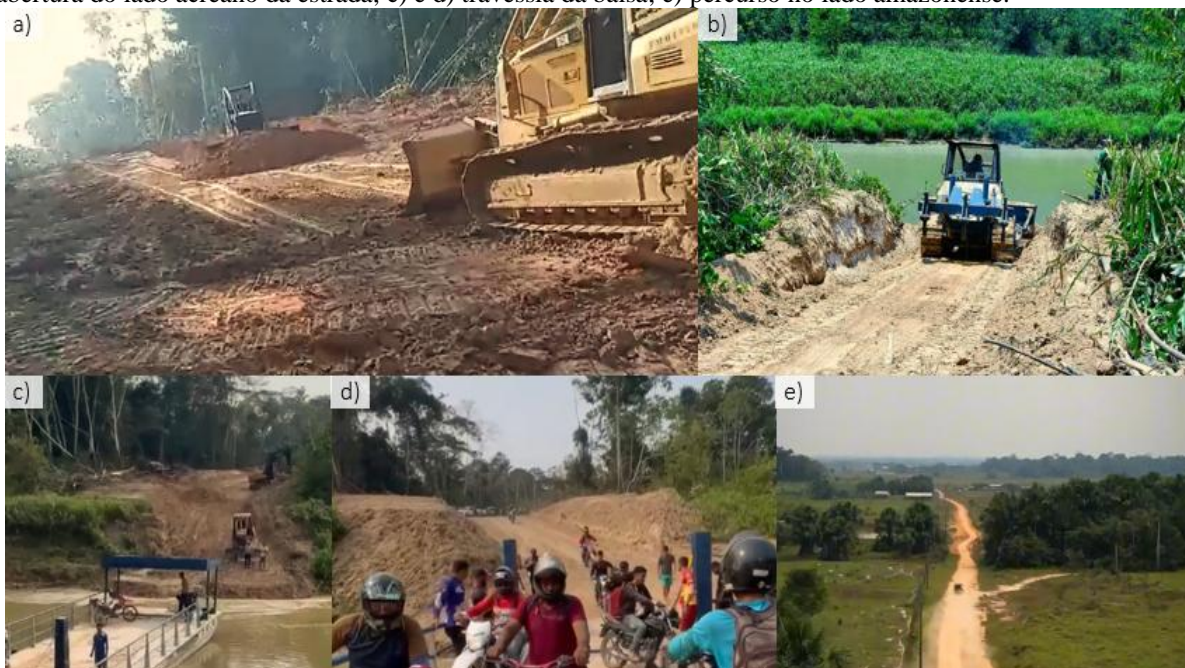
Figura 2 - Construção da estrada Feijó-Envira: a) abertura da estrada com máquinas; b) trator de esteira finalizando abertura do lado acreano da estrada; c) e d) travessia da balsa; e) percurso no lado amazonense.
