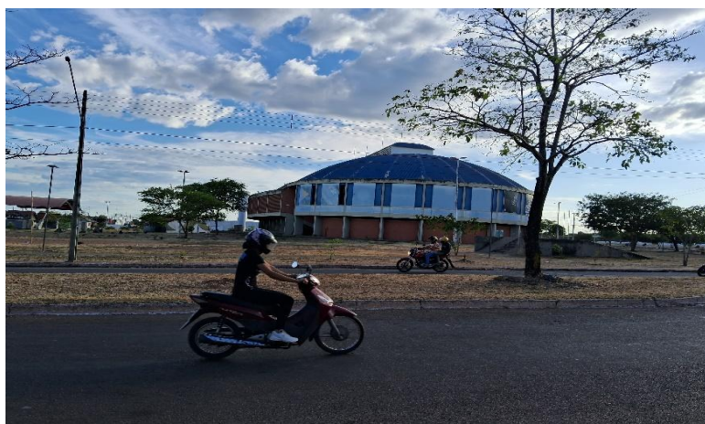
Figura 1- Vista do Ginásio Ayrton Senna
