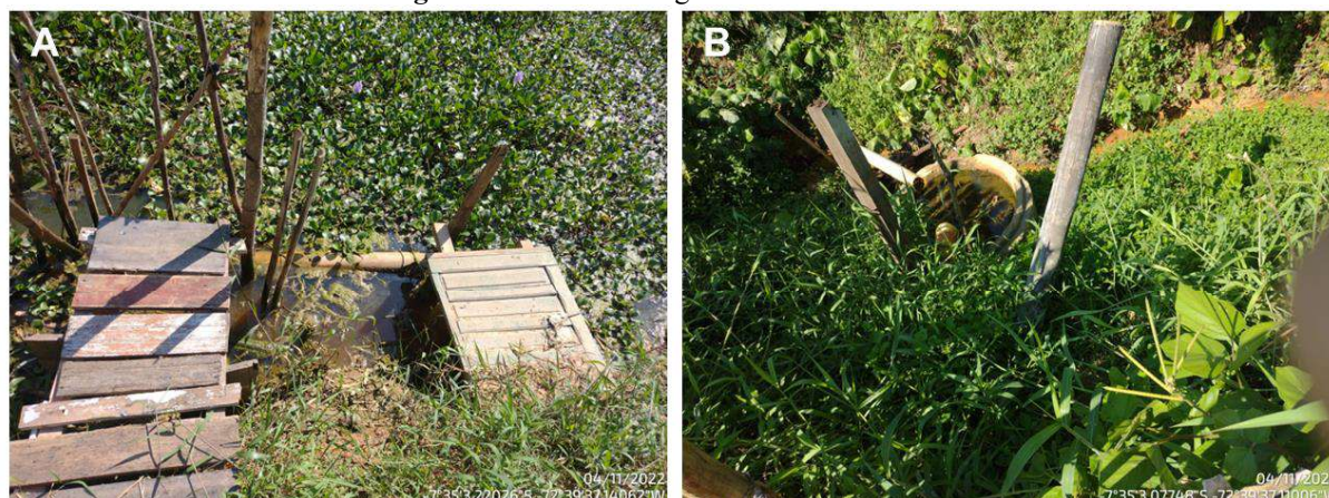
Figura 4 - Filtro e córrego no entorno do lixão.
