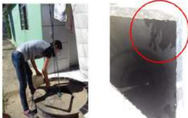
Figura 7- Imagens do poço 2 em Presidente Médici, tampa e revestimento interno.
