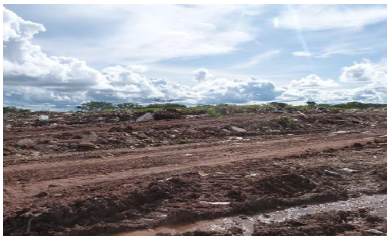
Figura 6: Melhoramento do nivelamento do terreno do Aterro de Inertes
