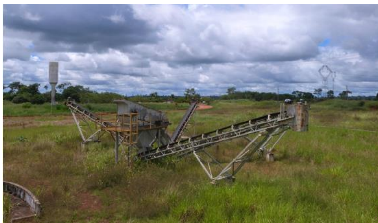
Figura 12: Britador 2 sem funcionamento
