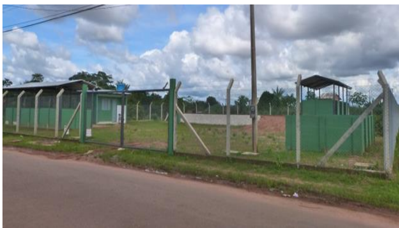
Figura 15: Ecoponto do município de Rio Branco no bairro Tucumã
