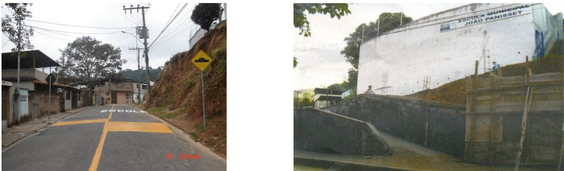
Figura 6: Construção do muro com rampa de acesso e proteção para os pedestres
